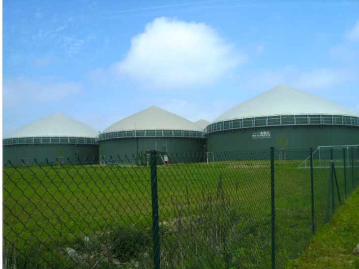
Foto: (Blick über den Zaun zur Biogasanlage hin)
