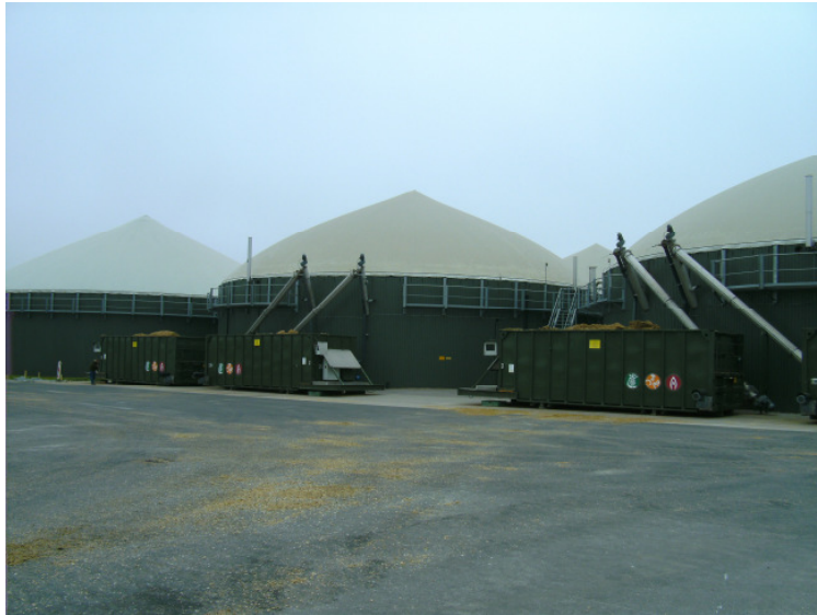
(Foto: drei Fermenter mit vorgelagerten Dosierautomaten)
